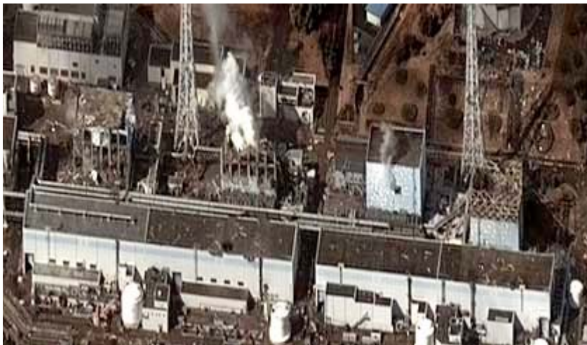
Atomkraftwerk Fukushima nach dem Erdbeben am 16. März 2011: ein Wendepunkt in der Geschichte Japans. (Bild: wikimedia)
